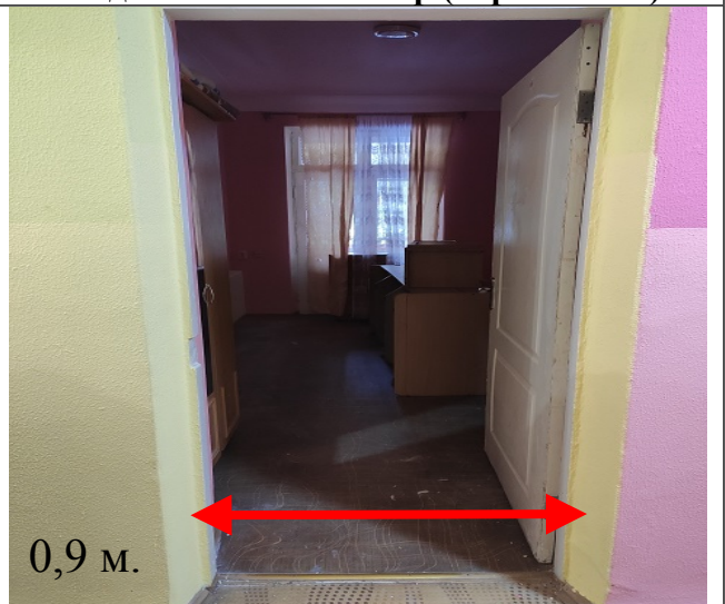
Фото №32 санузел общего пользования
