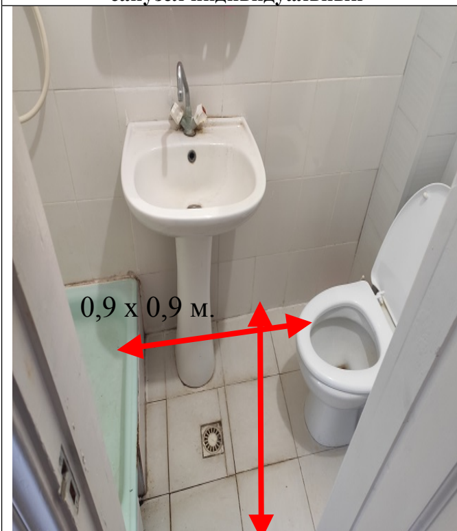
Фото №33 санитарная комната общего пользования
