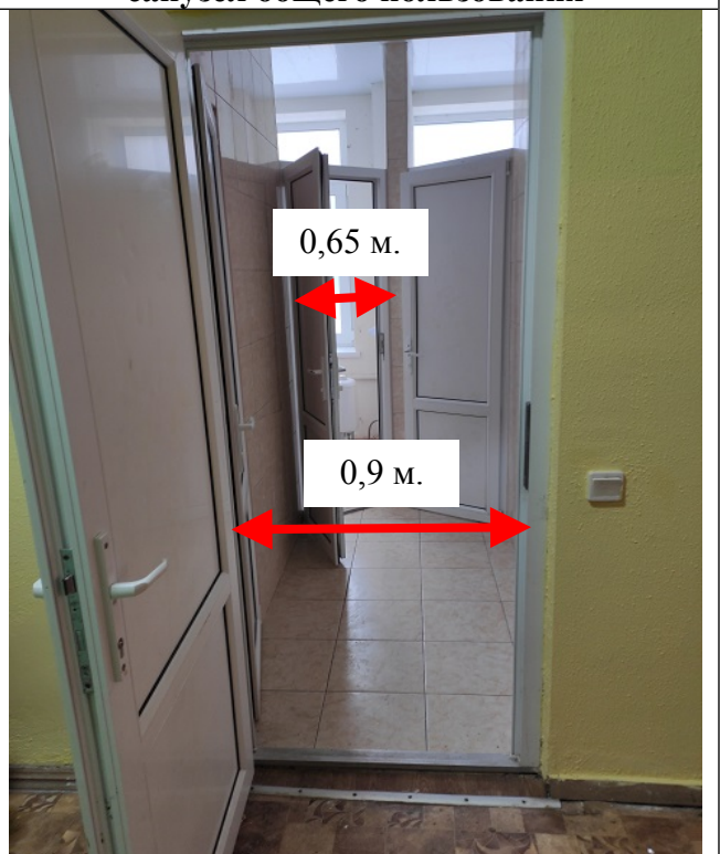
Фото №34 санузел общего пользования
