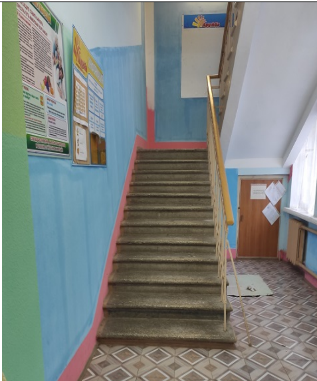
Фото №27 пути движения в здании (холл)
