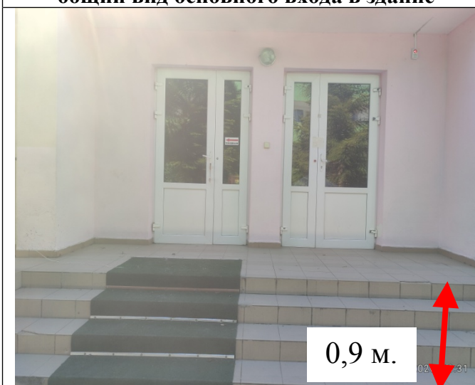
Фото №21 входная дверь в здание
